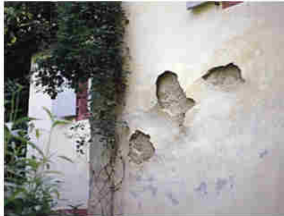
aufsteigende Feuchtigkeit
